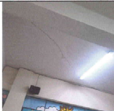
Foto 2: SELLO DE GRIETAS EN LOSA
