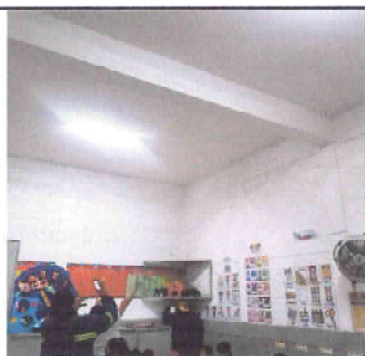
Foto 5: SELLADO DE GRIETAS EN LOSA DE AULAS
