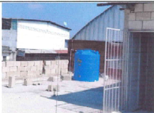
Foto1: REPARACIÓN Y MEJORAMIENTO DE MURO PERIMETRAL
