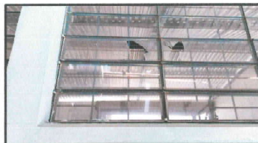
Foto 6: Sustitución de vidrios
