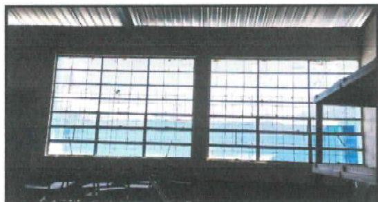
Foto 3: Mantenimiento a estructura de ventanas
