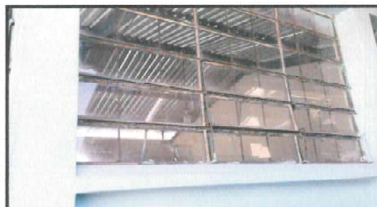
Foto4: Mantenimiento a estructura de ventanas
