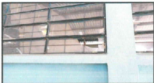
Foto 5: Sustitución de vidrios
