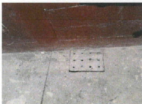
Foto 11: 11.3) Sustitución de parrilla para drenaje de cemento por metal, 4 parrillas de 0.40*0.30 mts.
