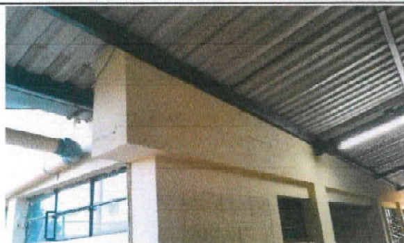
Foto 5: 7.7) Aplicación de impermeabilizante en canales de concreto, 30 ML.
