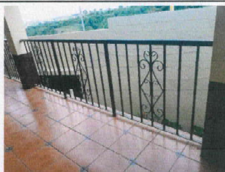
Foto 10: 11.1) Mantenimiento a barandas de metal, 80 ML.
