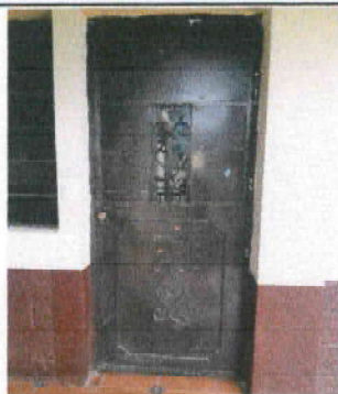
Foto 3: 4.1) Mantenimiento a estructura (lijado, cepillado aplicación de pintura) a 13 puertas de metal.
