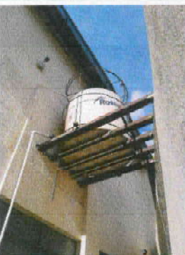
Foto 17: 18.2) Sustitución de depósito de agua de 1100 Lts, incluye cambio de tubería.
