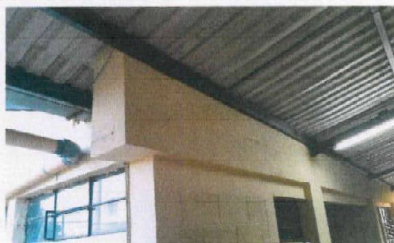
Foto 4: 7.6) Limpieza y mantenimiento de canales y bajadas de concreto, 30 ML.
