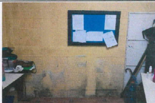
Foto 6: 9.1) Pintura en muros interiores, 95 M2.
