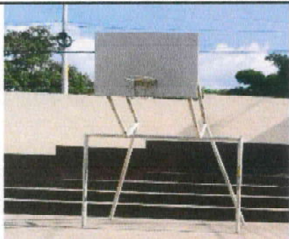
Foto 9: 9.2.1) Mantenimiento de marcos de portería y aro de basquetbol (lijado y aplicación de pintura)
