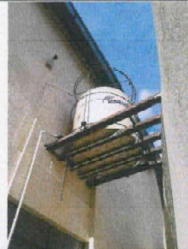
Foto 22: 19.7) Fabricación e instalación de estructura portante para soporte de deposito de agua.
