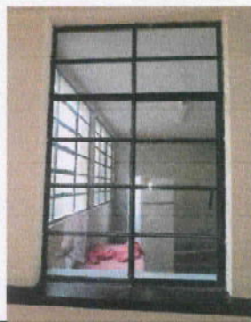
Foto 18: 19.2) Fabricación e instalación de balcon de hierro en ventana, 1 de 1.20*1.65 mts.
