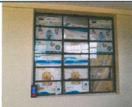
Foto 19: 19.2.1) Fabricación e instalación de balcon de hierro en ventana, 1 de 1.70*1.50 mts.
