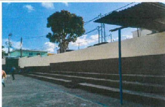
Foto1: 1.1) Sustitución y ampliación del techo del graderio, por lámina troquelada aluzinc calibre 26, 90 M2.
