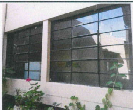
Foto 20: 19.2.2) Fabricación e instalación de hierro en ventana, 2 de 1.60*1.50 mts.
