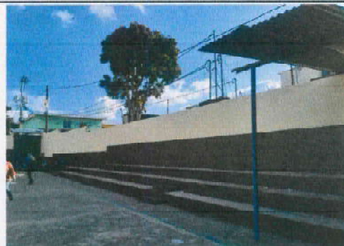
Foto 2: 2.3) Sustitución y ampliación de estructura de soporte de metal, por metal, 90 M2.
