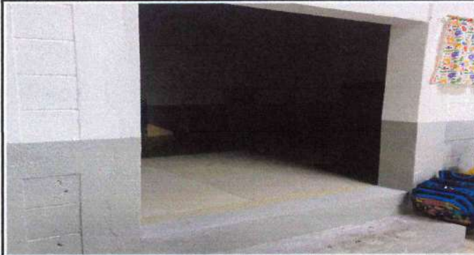
Foto 1: DEMOLICIÓN DE PARED DE BLOCK.
