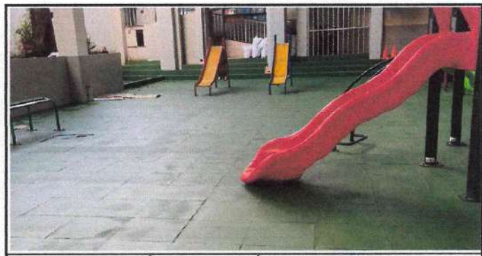
Foto 6: RESTAURACIÓN DE LOSA EN ÁREA RECREATIVA
