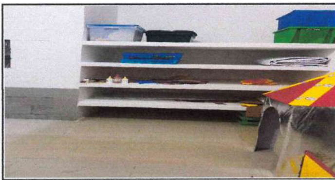
Foto 5: INSTALACIÓN DE DIVISIÓN DE TABLAROCA.
