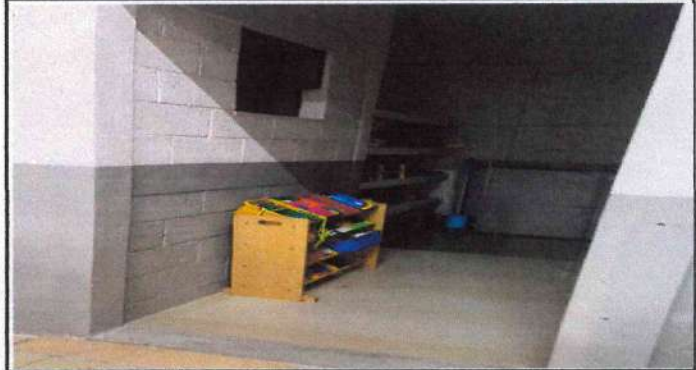
Foto 2: DEMOLICIÓN DE PARED DE BLOCK.
