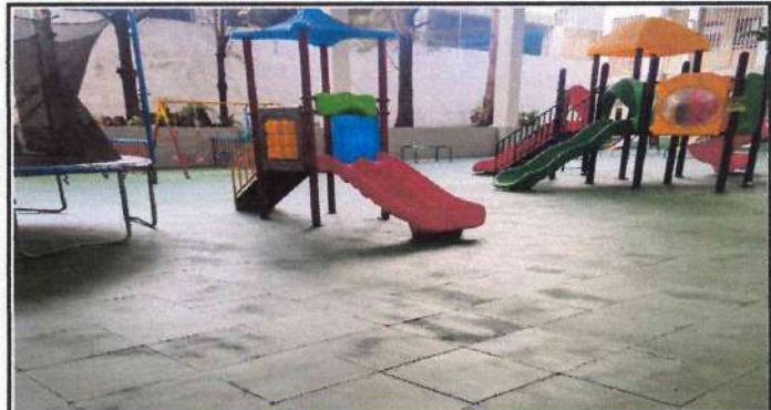
Foto 4: RESTAURACIÓN DE LOSA EN ÁREA RECREATIVA
