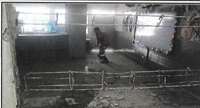
Foto 2: DEMOLICIÓN DE PARED DE BLOCK.
