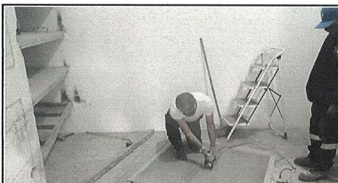
Foto 4: INSTALACIÓN DE DIVISIÓN DE TABLAROCA.
