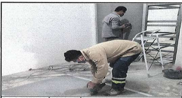
Foto 5: INSTALACIÓN DE DIVISIÓN DE TABLAROCA.
