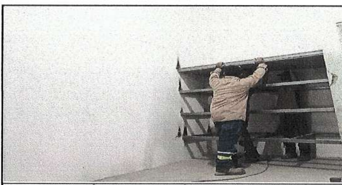
Foto 6: COLOCACIÓN DE MARCO METÁLICO PARA REFUERZO.
