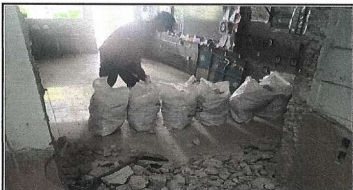
Foto 3: DEMOLICIÓN DE PARED DE BLOCK.
