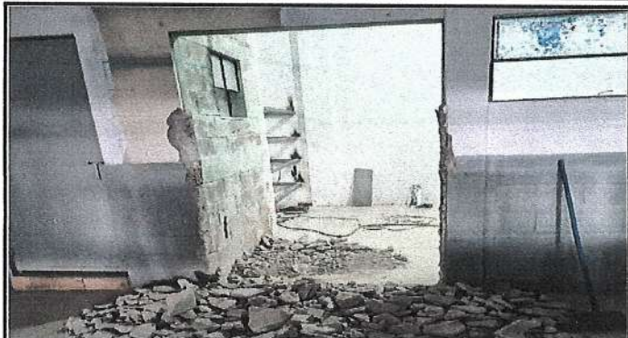
Foto 1: DEMOLICIÓN DE PARED DE BLOCK.
