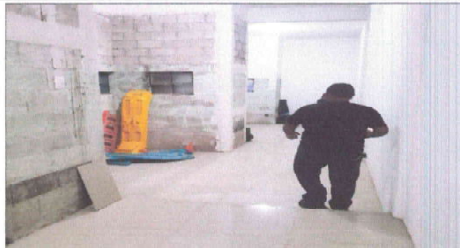
Foto 2: ESTRUCTURA DE METAL Y FORRADO DE TABLA ROCA
