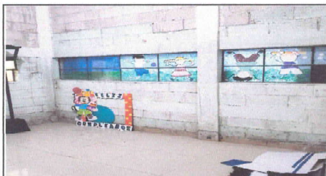
Foto 3: DEMOLICION DE PARED
