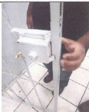
Foto 1: CAMBIO DE CHAPA
