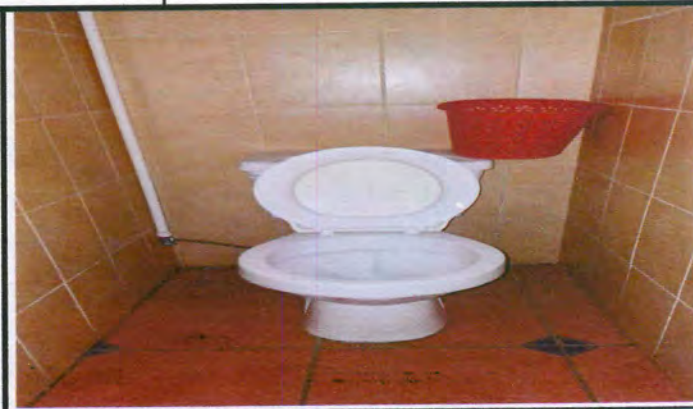
FOTO No. 9.1: REPARACIÓN DE TUBERÍA, LÍNEA PRINCIPAL DE LOS SANITARIO DE HOMBRES Y MUJERES DEL SEGUNDO MÓDULO, SE HARÁ ZANJA PARA INSERTAR LOS TUBOS, DEJANDO LA CONEXIÓN DE LOS INODOROS.
