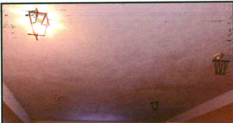
FOTO NO. 10: SUSTITUCIÓN DE 08 PLAFONERAS POR LÁMPARAS DE DOBLE TUBO LED DE 40 WATTS CON PROTECCIÓN Y HUMEDAD, EN LOS SERVICIOS SANITARIOS DE HOMBRES Y MUJERES DEL SEGUNDO Y TERCER MÓDULO.
