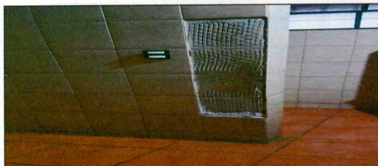
FOTO No. 8: SUSTITUCIÓN DE AZULEJOS EN VARIAS PARTES DE LOS BAÑOS DE HOMBRES Y MUJERES DEL SEGUNDO Y TERCER MÓDULO DONDE HACEN FALTA
