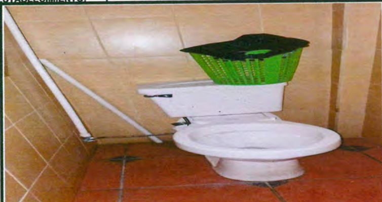
FOTO No. 9: REPARACIÓN DE TUBERÍA, LÍNEA PRINCIPAL DE LOS SANITARIOS DE HOMBRES Y MUJERES DEL SEGUNDO MÓDULO, SE HARÁ ZANJA PARA INSERTAR LOS TUBOS, DEJANDO LA CONEXIÓN DE LOS INODOROS.
