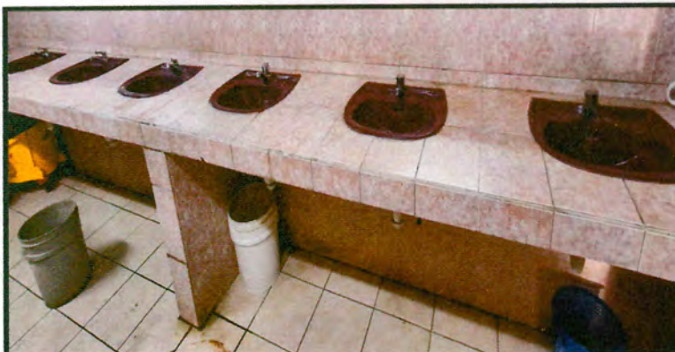
FOTO NO. 6.1: SUSTITUCIÓN DE 12 LAVAMANOS UBICADOS EN LOS SERVICIOS SANITARIOS DE HOMBRES Y MUJERES DEL PRIMER MÓDULO.
