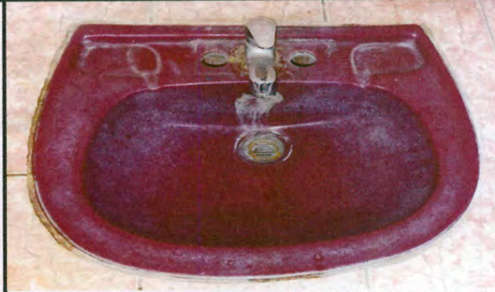
FOTO NO. 6: SUSTITUCIÓN E INSTALACIÓN DE 12 LAVAMANOS UBICADOS EN LOS SERVICIOS SANITARIOS DE HOMBRES Y MUJERES DEL PRIMER MÓDULO.
