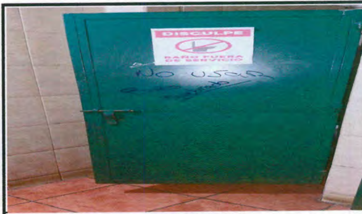
FOTO NO. 4: MANTENIMIENTO A 24 PUERTAS DE ENTRADA A CADA SERVICIO SANITARIO DE HOMBRES Y MUJERES DEL PRIMER, SEGUNDO Y TERCER MÓDULO, SE APLICARÁ: LIJADO, CEPILLADO, QUITAR SUJECCIONES POR LADO FUERA Y PINTURA
