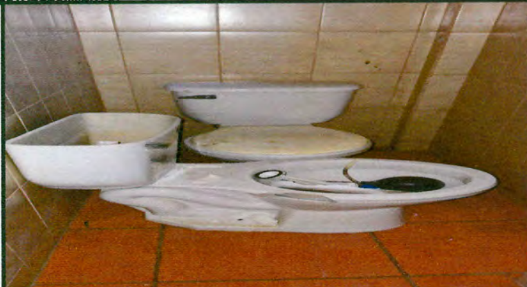
FOTO No. 5.1: SUSTITUCIÓN E INSTALACIÓN DE 24 INODOROS DE MUJERES Y HOMBRES QUE SE ENCUENTRAN EN EL PRIMER, SEGUNDO Y TERCER MÓDULO.
