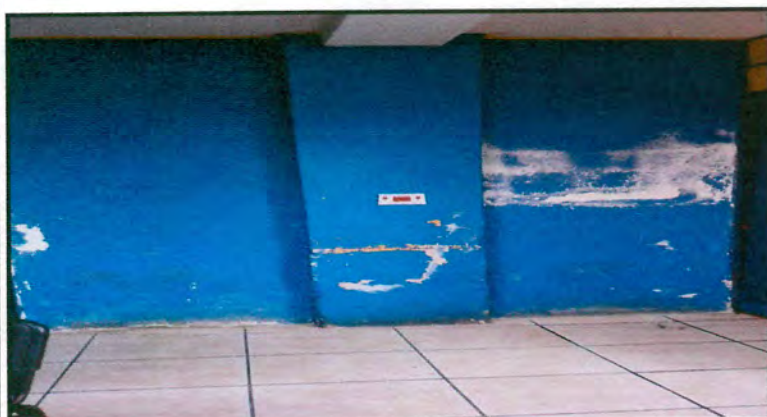
FOTO NO. 3: RESANAMIENTO DE PARED, APLICACIÓN DE QUÍMICOS Y PINTURA EN EL MURO INTERIOR, EN LA PARTE DE LA ENTRADA DE LOS SERVICIOS SANITARIOS DE MUJERES Y HOMBRES DEL PRIMER MÓDULO.
