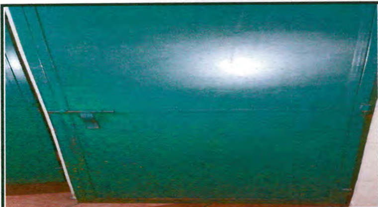
FOTO NO. 4.1: MANTENIMIENTO A 24 PUERTAS DE ENTRADA A CADA SERVICIO SANITARIO DE HOMBRES Y MUJERES DEL PRIMER, SEGUNDO Y TERCER MÓDULO, SE APLICARÁ: LIJADO, CEPILLADO, QUITAR SUJECCIONES POR LADO FUERA Y PINTURA
