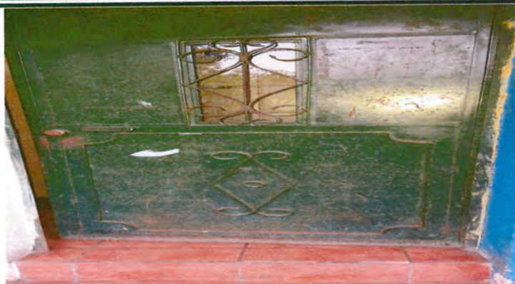
FOTO NO. 1: MANTENIMIENTO A 4 PUERTAS DE ENTRADA PRINCIPAL DE SANITARIOS DE HOMBRES Y MUJERES DEL PRIMER y TERCER MÓDULO, SE APLICARÁ: LIJADO, CEPILLADO Y PINTURA
