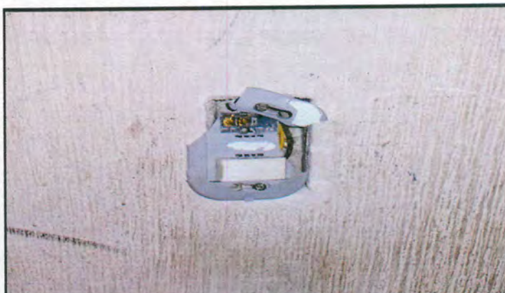
FOTO NO. 11: SUSTITUCIÓN DE 4 INTERRUPTORES UBICADOS EN LOS SERVICIOS SANITARIOS DE HOMBRES Y MUJERES DEL SEGUNDO Y TERCER MÓDULO-
