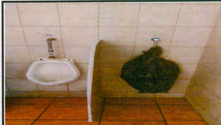
FOTO No. 7: SUSTITUCIÓN E INSTALACIÓN DE 05 MINGUITORIOS, UBICADOS EN LOS BAÑOS DE HOMBRES DEL PRIMER, SEGUNDO Y TERCER MÓDULO, ASÍ COMO SUSTITUCIÓN DE LA DIVISIÓN DE CADA UNO.
