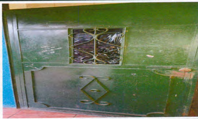
FOTO NO. 2: SUSTITUCIÓN DE VIDRIO A PUERTA UBICADA EN LA ENTRADA PRINCIPAL DE SERVICIOS SANITARIOS DE MUJERES DEL TERCER MÓDULO.
