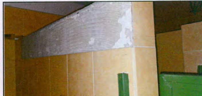
FOTO No. 8.1: SUSTITUCIÓN DE AZULEJOS EN VARIAS PARTES DE LOS BAÑOS DE HOMBRES Y MUJERES DEL SEGUNDO Y TERCER MÓDULO DONDE HACEN FALTA
