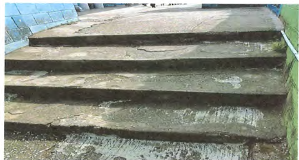
Reparación de planchas de concreto de patio (reparación de gradas)
