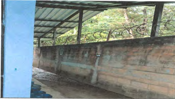
Pintura en muros exteriores e interiores
