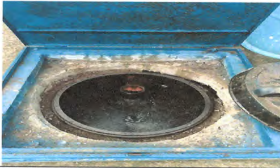
Limpieza de fosa séptica
