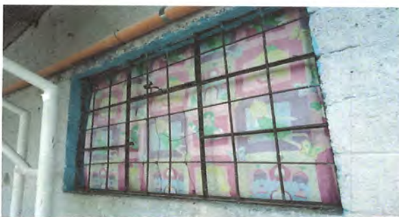
Suministro e instalación de balcones de hierro
