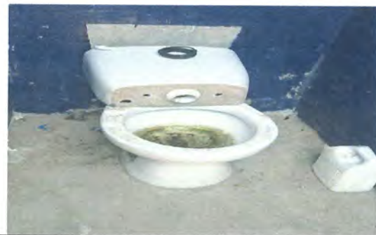
Sustitución de inodoro
