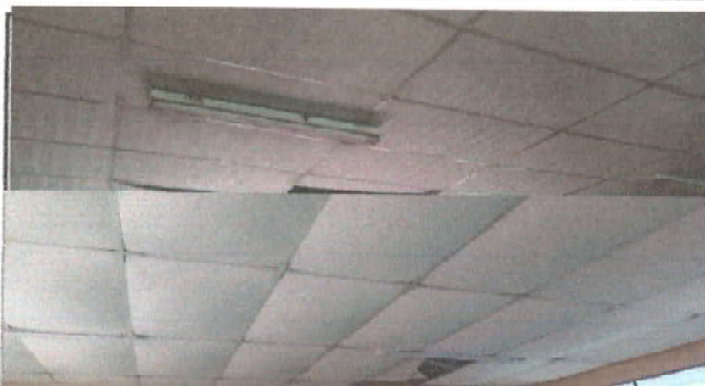
Foto 1: REPARACIÓN PANELES DE SALONES MODULO #2
