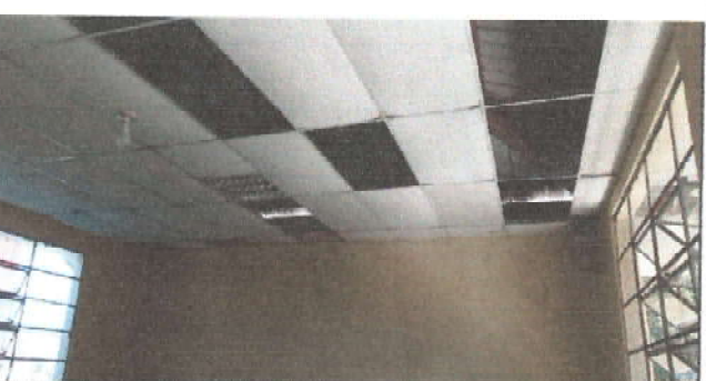
Foto 1: REPARACIÓN PANELES DE SALONES MODULO #3
