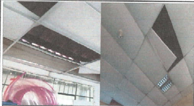
Foto 1: REPARACIÓN PANELES DE SALONES MODULO 1
