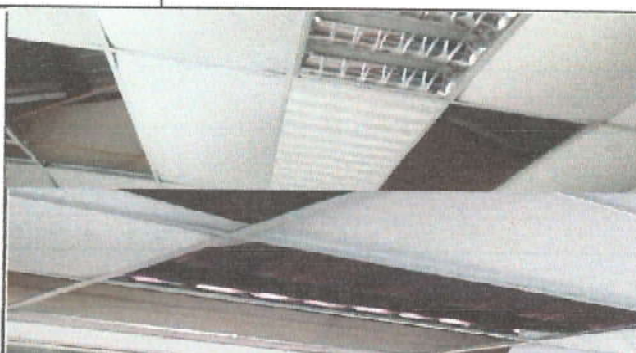
Foto 2: REPARACIÓN PANELES DE SALONES MODULO #1
