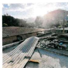
Foto 4: Limpieza de losa dirección y secretaria
