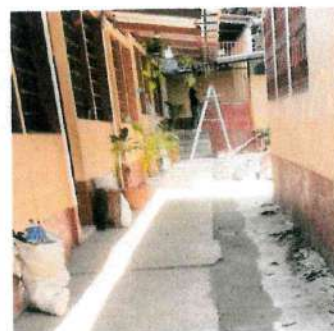
Foto 4: Techado de area de pila
