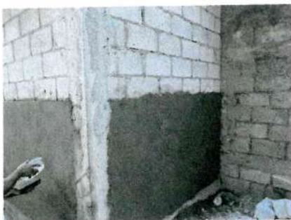
Foto 3: Impermeabilización de pared con cemento.
