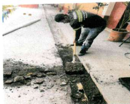
Foto 2: limpieza de cuneta
