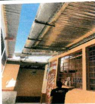
Foto1: retirar cubierta de lamina
