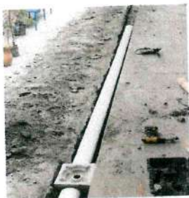
Foto 1: instalación de tubería en cuneta
