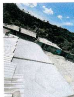
Foto 2: Impermeabilización de Losa
