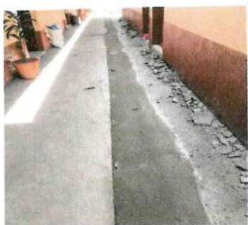
Foto 3: Aplicación de Cemento en cuneta
