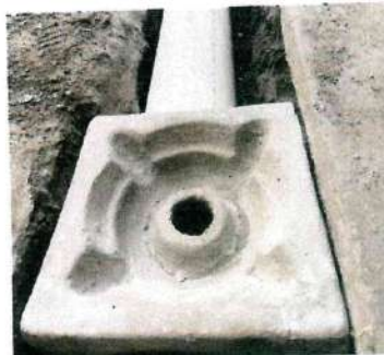
Foto 2: Instalacion de reposaderas
