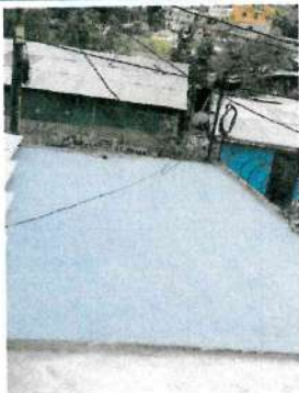
Foto1: Impermeabilización de Losa
