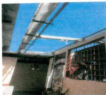
Foto 3: limpieza y pintura de estructura de lamina
