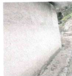
Foto 4: Impermeabilización de Pared con cemento
