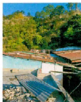
Foto 2: impermeabilizacion de techo
