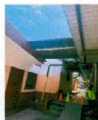
Foto 6:modulo 3: cambio de estuctura de techo
