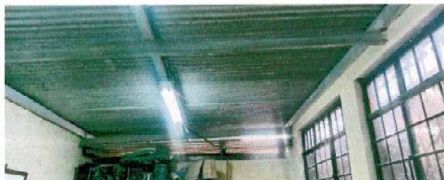
Foto1:modulo 1 :cambio de estructura de techo
