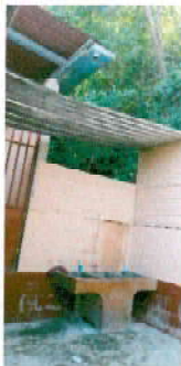
Foto 3: modulo 2: cambio de estructura de techo
