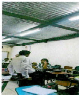
Foto 5: modulo 1: cambio de estructura de techo
