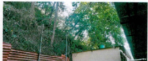
Foto 6: modulo 1 :cambio de estructura de techo
