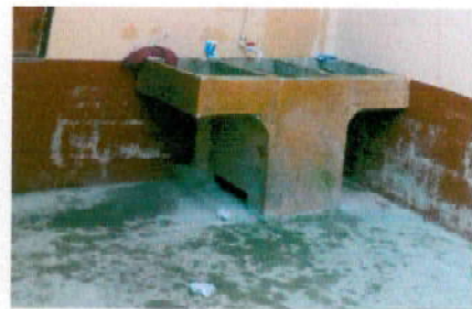
Foto 4: sustitucion de chorro de bronce
