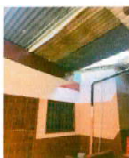
Foto 5:modulo 3: cambio de tructura de techo
