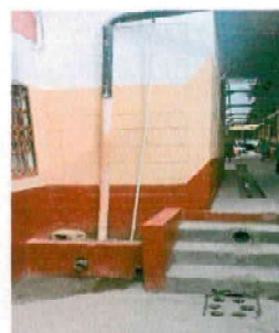
Foto 4: reparacion de bajada pluvial
