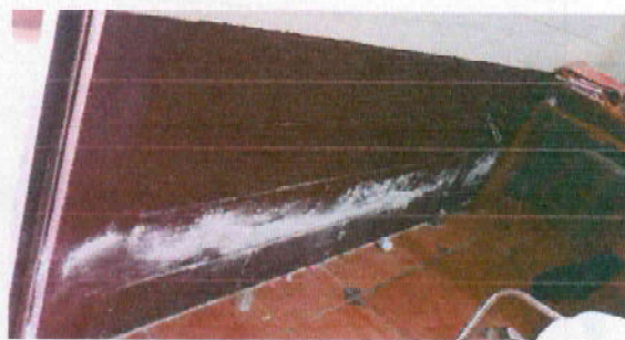
FOTO #02: APLICACIÓN DE CERNIDO EN MUROS EXTERIORES
