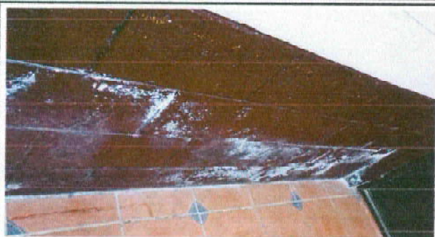
FOTO #01: PINTURA EN MUROS EXTERIORES
