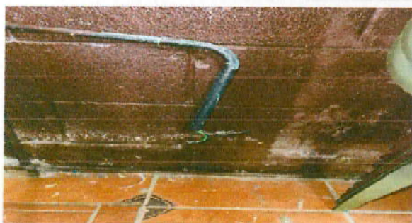
FOTO#05: INSTALACION DE UNIDADES DE FUERZA (TOMA CORRIENTES) CON CABLEADO
