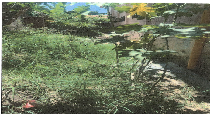
Foto 3: Cuneta de concreto, limpieza de la misma de aguas residuales y tierra 48 mts lineales.
