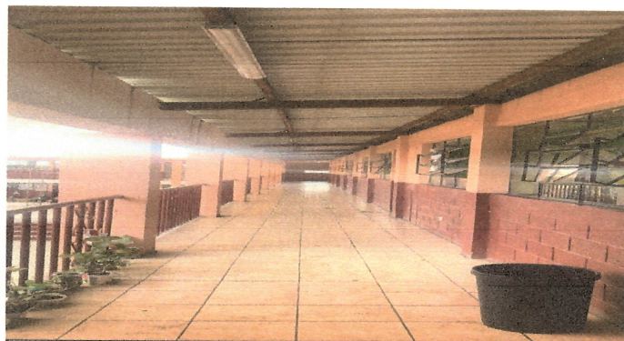
Foto 4: Sustitución de lamina, por lamina troquelada aluzinc calibre 26 en área de aulas de segundo nivel dando como metraje 185 mts cuadrados.
