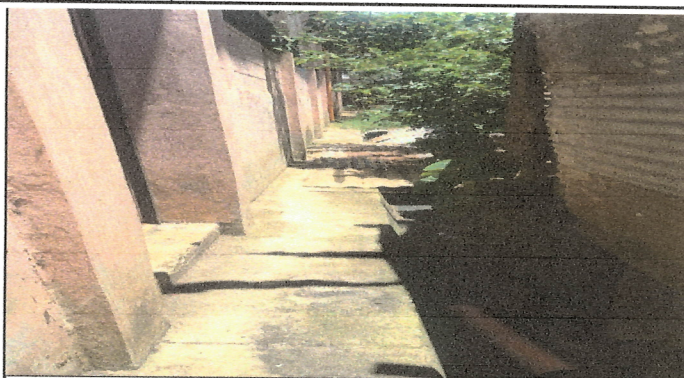
Foto 2: Impermeabilización de pared lateral de escuela de medidas de 48 mts de largo por 3 mts de alto.
