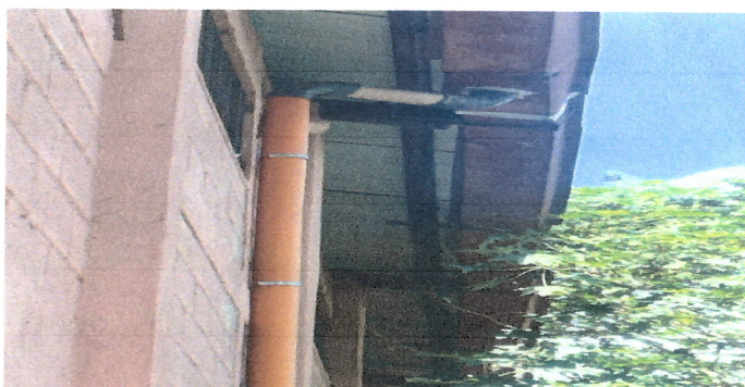
Foto 6: Reparación de bajada de agua pluvial, tubo de 3 pulgadas PVC, con sus accesorios correspondientes dando como medida 72 mts lineales.
