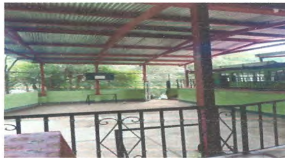
FOTO 4: Aplicación de pintura anticorrosiva a estructura de cancha
