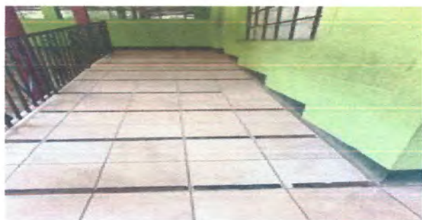
FOTO 9: Sustitución de piso cerámico por piso cerámico antideslizante en rampa
