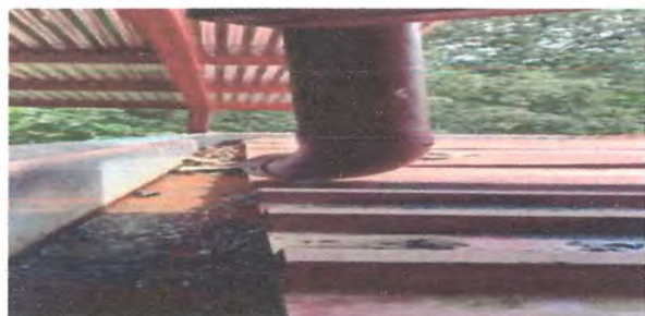
FOTO 11: Limpieza a de canales de metal
