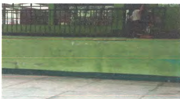
FOTO 13: Sustitución de pintura en muros interiores
