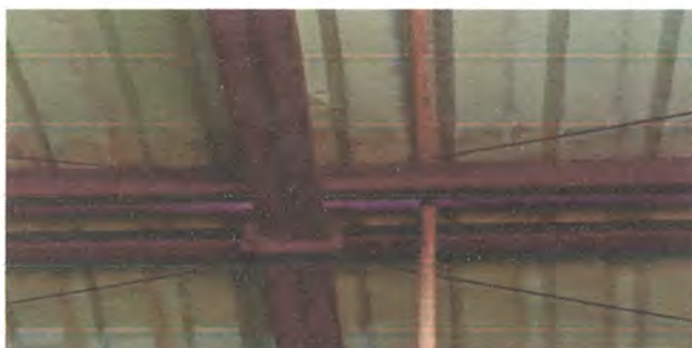
FOTO 3: Mantenimiento estructura de metal y pintura anticorrosiva R15 a 5 salones baños y Dirección
