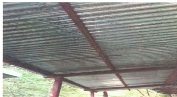
FOTO 2: Sustrucción de lámina de pasillo por lámina troquelada aluzinc calibre 26
