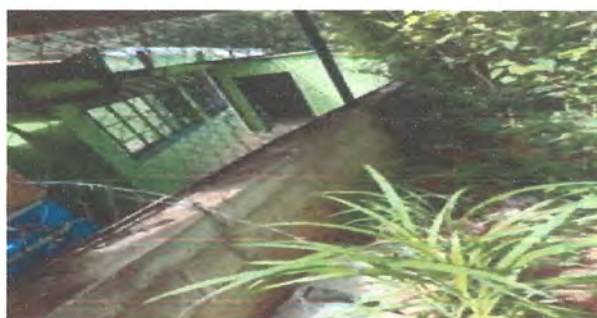
FOTO 16: Aplicación de repello, alizado, y de impermeabilizante en parte exterior en muro perimetral de patio posterior, (Incluye zanjeo y relleno en el area donde se realizará la impermeabilización)
