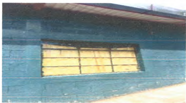
FOTO 7: Suministro e instalación de balcón con angular de 3/4 y hierro de 1/2 de 1.90 X 1.40 mts
