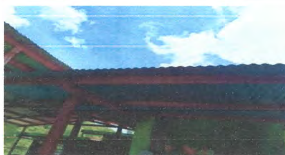
FOTO 10: Instalación de canal de metal calibre 26 y soportería
