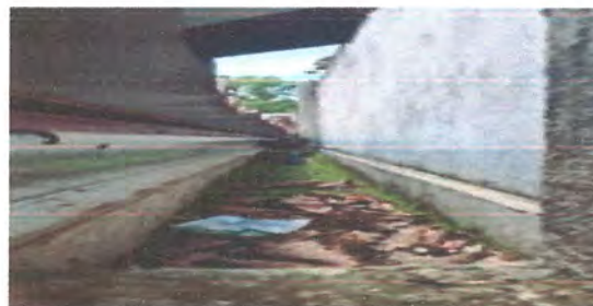
FOTO 12: Aplicación de impermeabilizante a canal de concreto
