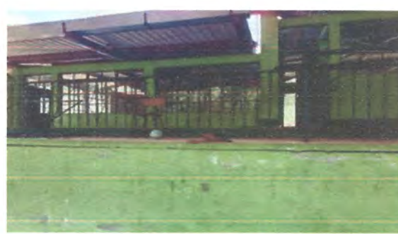
FOTO 8: Sustitución de torta de concreto en escenario, (incluye demolición de torta de concreto existente, excavación compactación, nivelación de suelo y fundición de nueva torta de concreto de 10 cms de grosor y electromalla)
