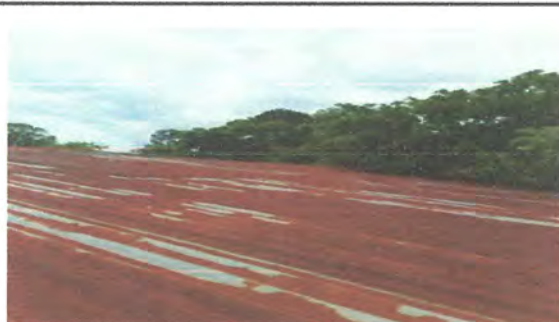
FOTO 1: Sustrucción de lámina de techado de cancha por lámina troquelada aluzinc calibre 26
