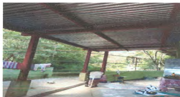
FOTO 6: Aplicación de pintura a estructura de pasillo
