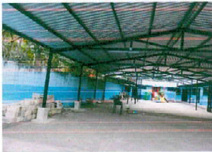
Foto 3: Instalación de canales de metal en el corredor de cocina y corredores en la Escuela
