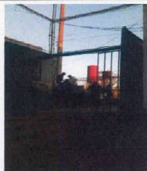
Foto 2: REPARACIÓN E INSTALACIÓN DE PUERTA CORREDIZA PRINCIPAL CON CHAPA, UBICADO MÓDULO #1
