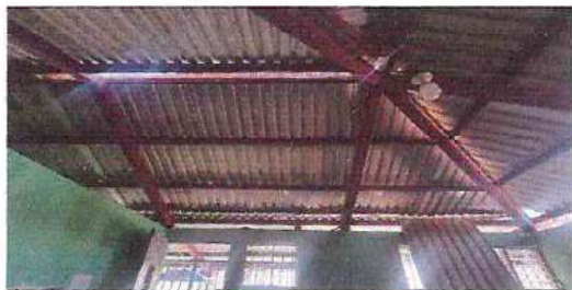
Foto1: Sustitución de láminas troquelada aluzinc calibre 26
