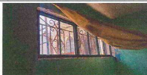
Foto 4: Sustitución de ventanade madera por ventanas de metal + vidrio
