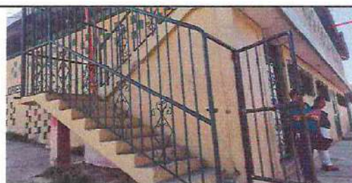
Foto 6: Mantenimiento de barandas de metal
