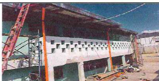
Foto 5: Sustitución de canal metálico + bajadas de agua con tubo pvc 3" para drenaje pluvial
