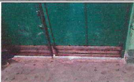
Foto 3: Sustitución de chapa de portón de entrada principal y mantenimiento de portón de entrada
