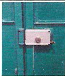
Foto 3: Sustitución de chapa de portón de entrada principal y mantenimiento de portón de entrada
