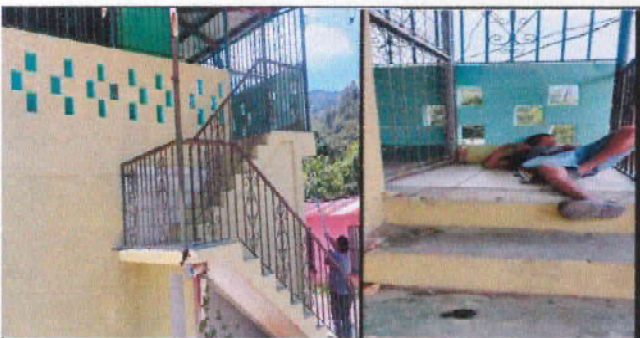
Foto 11: Ampleación de estas rejas y una reja de entrada a las gradas para evitar que sigan entrando personas a consumir sustancias dañinas a una de las entradas principales del establecimiento
