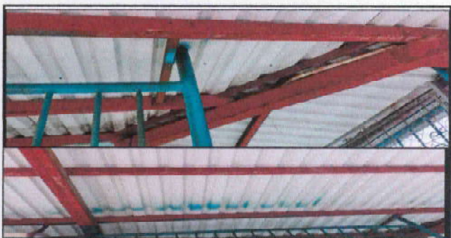
Foto 12: Pintura y mantenimiento a costaneras del techo, en especial a las de los pasillos de alrededor que estan dentro del establecimiento, por presentar oxidación por el deterioro de de pintura.
