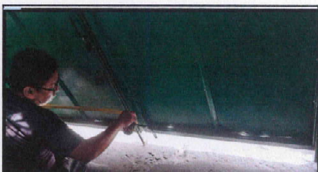
Foto 9: Reparación y ampleación del porton principal del establecimiento, ya que por tener mucho espacio de luz se desnivela y provoca que se arruinen las chapas continuamente.
