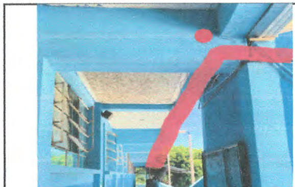
FOTO 4: Instalación de entubado y cableado de 3 líneas calibre 10 (64 mt), sobre cornisa de terraza de pasillo principal de aulas.
