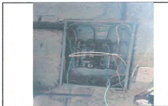
FOTO 6: Instalación de nuevo tablero de control de 16 breakers
