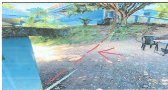
FOTO 5: Instalación de línea eléctrica y ducto enterrado para la bomba de agua
