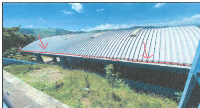
FOTO 3: Instalación de entubado y cableado de 3 líneas calibre 4 (62 mt), sobre cornisa de techo del gimnasio
