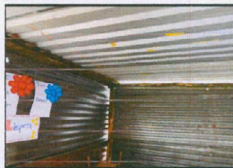
Foto 4: Sustitución de lámina, por lámina troquelada aluzinc calibre 26
