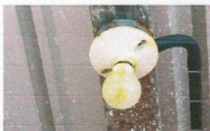
Foto1: Sustitución de ducto eléctrico + accesorios
