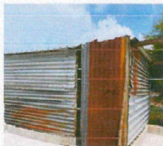
Foto 5: instalación de puerta de metal
