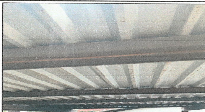
Foto 2: Sustrucción de estructura de metal por nueva estructura metal
