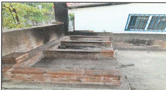
Foto 4: Sustrucción de estufa rural (completa)
