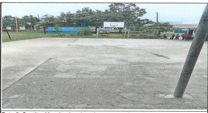
Foto 5: Sustrucción de planchas de concreto de patio
