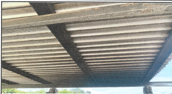
Foto1: Sustrucción de lamina por lamina aluzinc
