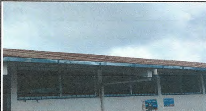
Foto1: Sustrucción de lamina modulo 1
