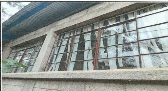
Foto 4: Instalación y fabricación de balcon
