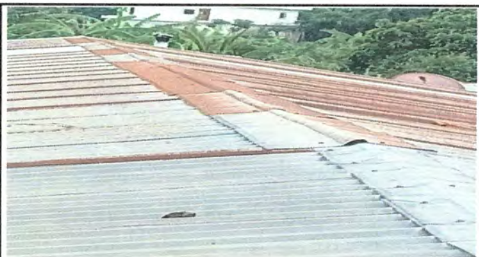
Foto 3: Sustrucción de capote del modulo 1
