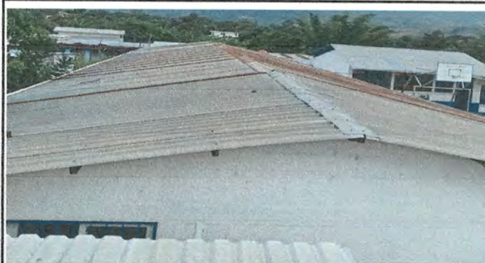
Foto2: Sustrucción de lamina modulo 1
