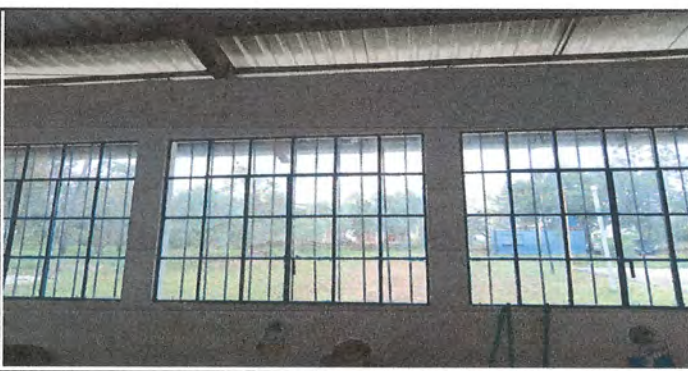
Foto 5: Sustrucción de ventana por ventana de pvc
