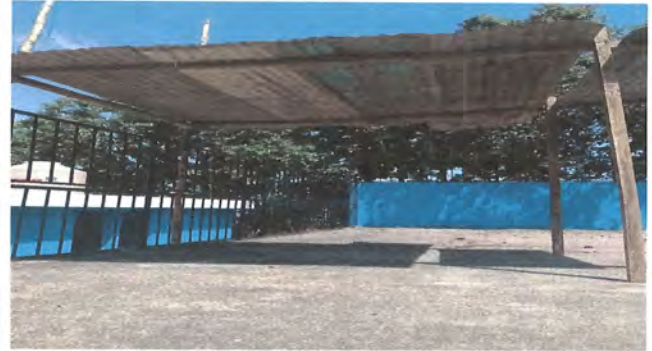
Foto 2: Techo de que se utiliza para actividades culturales lo cual muestra la foto, ya que solo ese espacio existe para realizarlas.
