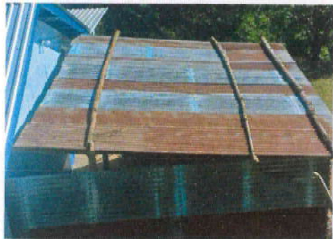
Foto 1: Sustrucción de lámina, por lámina troquelada aluzinc calibre 26 , (incluye sustrucción de 7 ML de capote)
