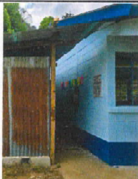
Foto 3: Sustrucción de puerta de lámina por puerta de metal.
