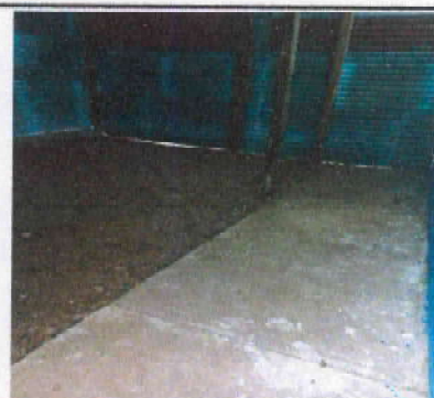
Foto 4: Nivelación de piso de torta de concreto e instalación de piso de granito.
