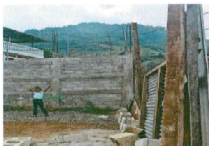
Foto 1: Reparación de muro perimetral de block con tubo hg y malla galvanizadas, soleras intermedias y columnas
