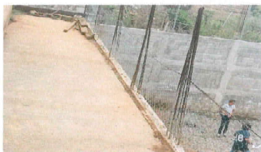
Foto11: Sustitución de piso de torta de concreto (levantado de torta dañada y fundición de torta nueva con electromalla).
