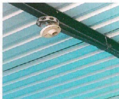
Foto 10: Sustitución de conducto eléctrico más accesorio( plafoneras, interruptores simples y tomacorrientes
