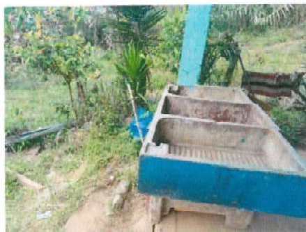
Foto 15: Sustitución de mezcladora lavamanos (contra llave, tubo de abasto) Instalación de lavamanos de base de block con azulejo que incluye 4 grifos
