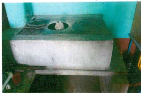
Foto13: Instalacion de azulejo en la estufa rural.
