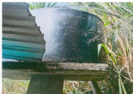
Foto 8: sustitución de deposito de agua 1000 lt
