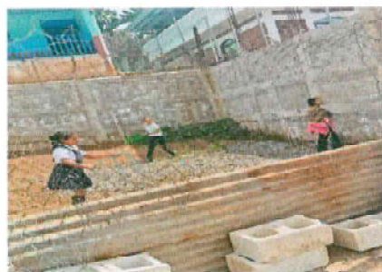
Foto 3: Reparación de muro perimetral de block con tubo hg y malla galvanizadas, soleras intermedias y columnas
