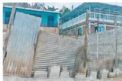
Foto 2: Reparación de muro perimetral de block con tubo hg y malla galvanizadas, soleras intermedias y columnas
