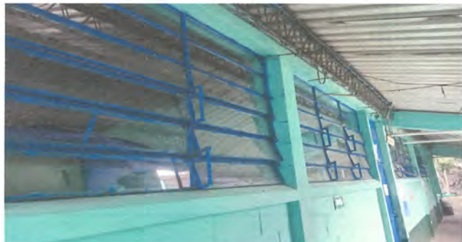
Foto 1: CAMBIO DE LA ESTRUCTURA DE LA VENTANA POR VENTANA PVC CORREDIZAS
