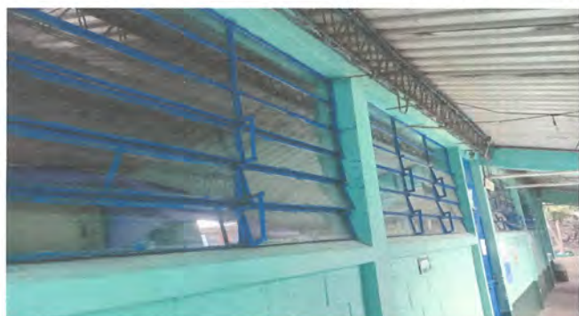
Foto 3: INSTALACION DE BALCONES DE METAL EN VENTANAS
