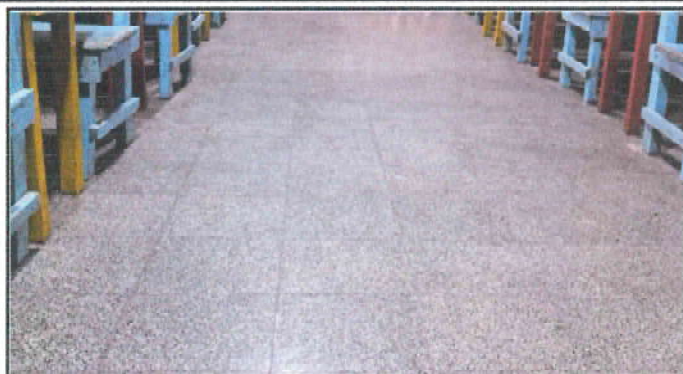
Foto 7: Reparación de piso de granito
