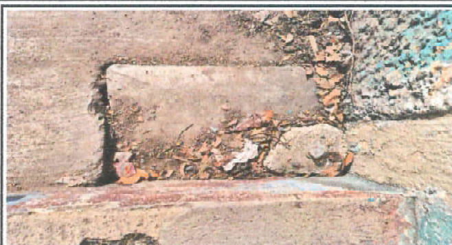
Foto 8: Sustitución de caja de registro
