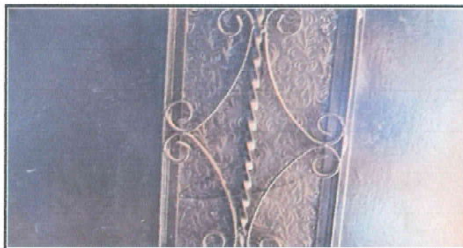
Foto 6: Sustitución de vidrio
