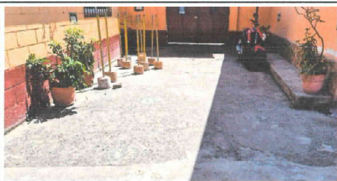
Foto 3: Reparación de piso de torta de concreto
