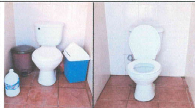
Foto 4: Sustitución de inodoros
