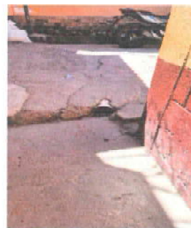
Foto 2: Sustitución de tubería PVC línea principal aguas pluviales
