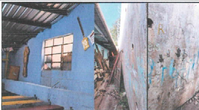
Foto 1: Reparación de muro de contención
