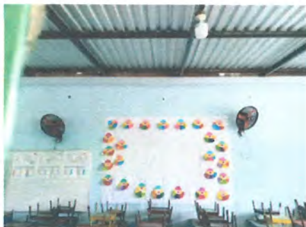
Foto 3: Sustitución de ducto eléctrico más accesorios para instalación eléctrica para ventiladores
