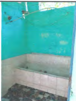
Foto 1: Remodelación de migtorio
