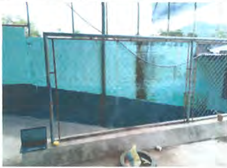
Foto1: SUSTITUCION DE MALLA POR MALLA GALVANIZADA CON PLATINA METALICA Y SOPORTE INTERMEDIO DE TUBO GALVANIZADO
