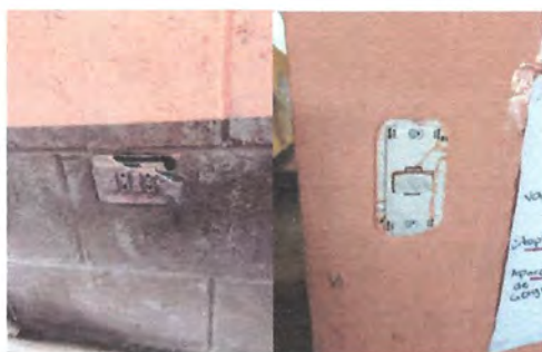
Foto 15: Sustitucion de interruptores dobles y tomacorrientes dobles
