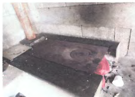
Foto 8: Instalación de azulejo en estufa rural e instalación de chimenea de concreto
