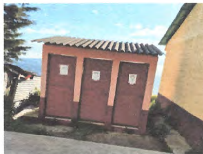
Foto 12: Sustitución de lámina duralita por lámina troquelada calibre 26 en baño
