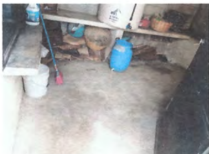
Foto 1: Suministro e instalacion de puertas de metal corredizas en mueble de cocina
