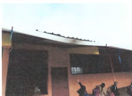
Foto 9: Sustitución de pescante de metal para canal de agua pluvial
