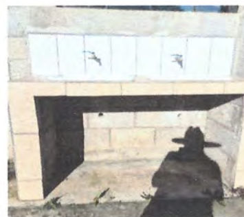
Foto 16: suministroe instalacion de puertas de metal corredizas en mueble de lavamanos
