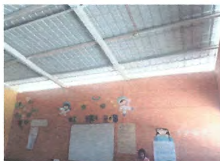
Foto 14: Mejoramiento de muro de aula que da a la calle para cerramiento por seguridad de los niños
