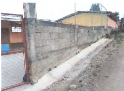
Foto 13: Instalacion de Razzor Rebon en muro perimetral de malla del frente de la escuela, Reparacion de tubo y malla galvanizada
