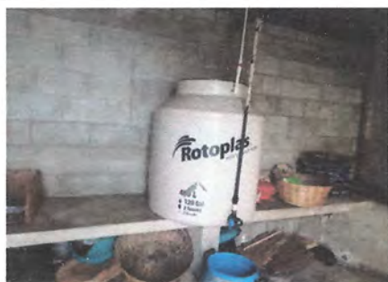
Foto 17: instalacion de accesorios de rotoplast tapadera (ttuberiade de salida de agua y respiradero)
