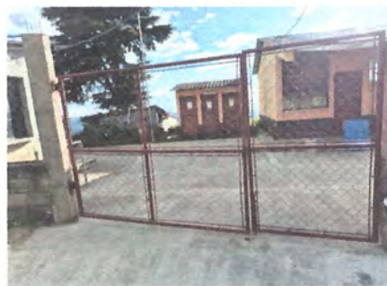
Foto 2: Sustitución de portón de malla por portón de láminas de hacero
