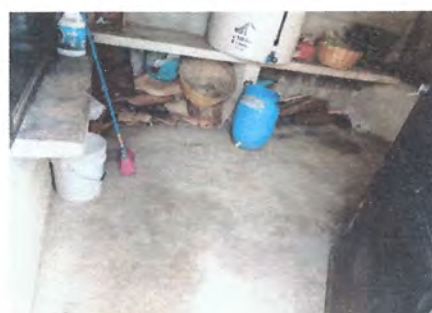
Foto 4: Sustitucion de piso de concreto por piso cerámico en cocina
