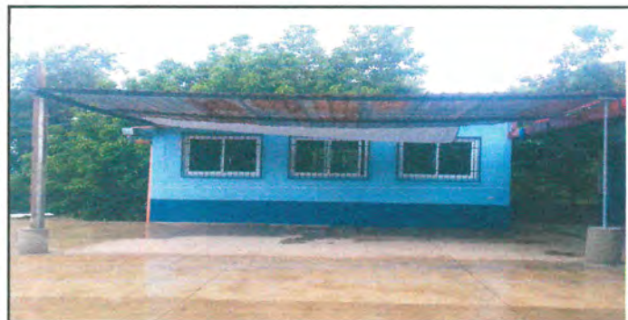
Foto 3: Muestra el techado de la galera, parte frontal.
