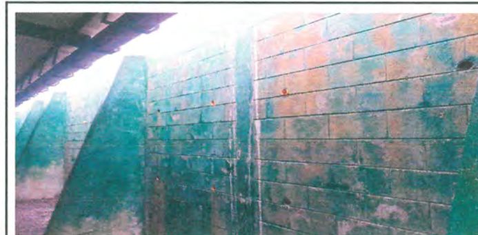
Foto 5: Muestra interior del muro a remodelar pintura.
