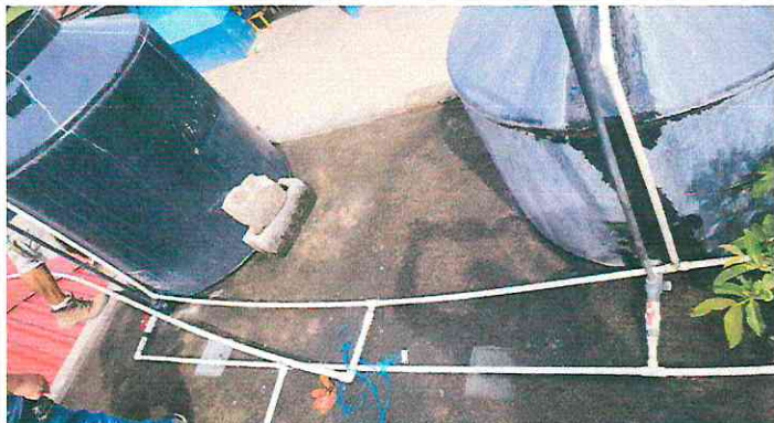
Foto 7: Sustrucción de accesorios de depositos de agua, colocacion de 5 cheques y 5 llaves de paso y reubicacion de tuberias en tinacos para mejor funcionaiento.
