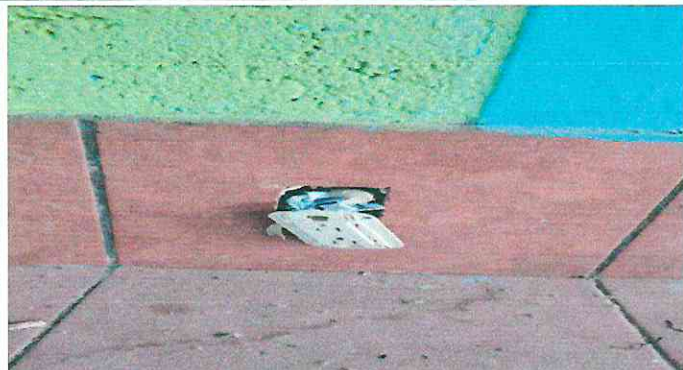
Foto 1: Instalación de unidad de fuerza (tomacorrientes) incluye cable eléctrico 15 en aulas y corredor de escuela.
