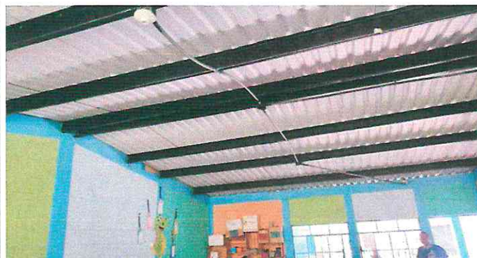
Foto 3: Sustitución de luces ahorradoras por luces led de 48 pulgadas con sus bases en 4 aulas, corredores y salón de usos múltiples en total 23 luces.
