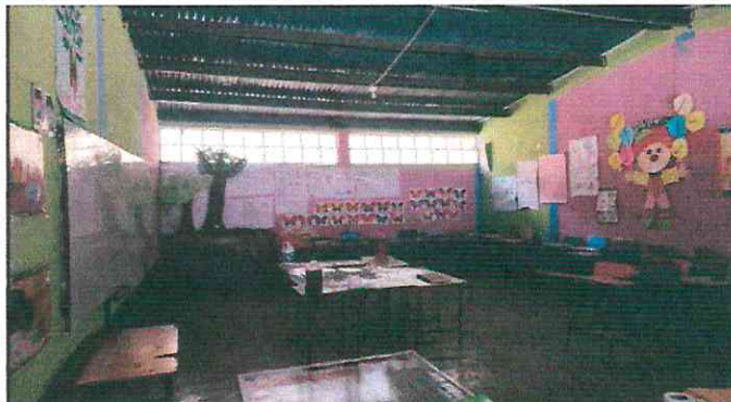
Foto 2: Ampliación de vano de ventana para mejorar ventilación e iluminación
