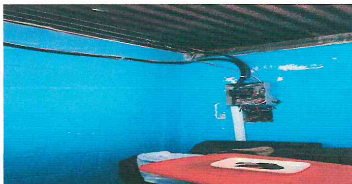
Foto 12: Reparacion de cableado electrico de area de direccion hacia aulas danto como total 75 mts lineales.
