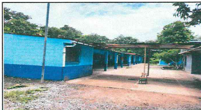
Foto 4: Instalación de estructura portante de metal en área de patio de escuela de 12.60 mts de largo por 7 mts de ancho con tubería de 2x2 para tendales y marcos.
