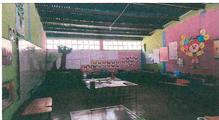
Foto 9: Sustrucción de estructura de metal de ventana por ventanas de pvc blanco con vidrio trasparente de 5 mm de grosor corredizas y con sus cerrojos.
