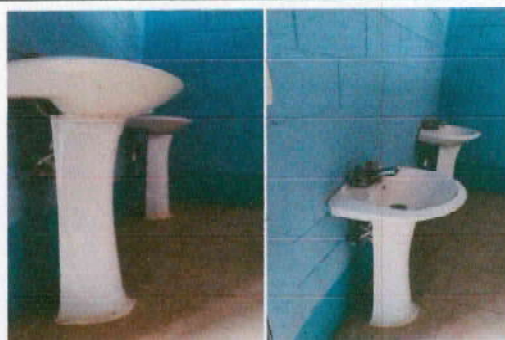
Foto 6: Sustrucción de lavamanos en sanitarios
