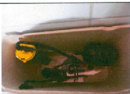
Foto 5: Sustrucción de accesorios de inodoro
