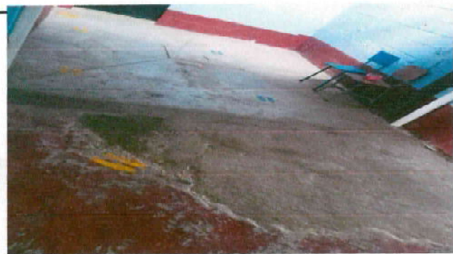
Foto 3: Sustrucción de piso de torta de concreto por piso cerámico
