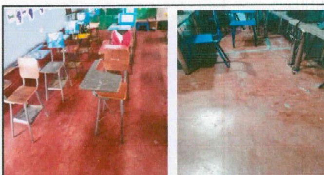
Foto 4: Sustrucción de piso de torta de concreto por piso cerámico
