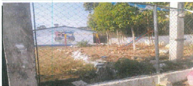
Reparacion de muro perimetral de bloc con tubo hg y maya galvanizada
