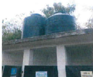
Foto 3: reparación y sustitución de tinaco
