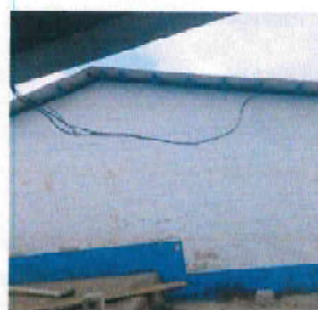
Foto 6: sustitución de lamina
