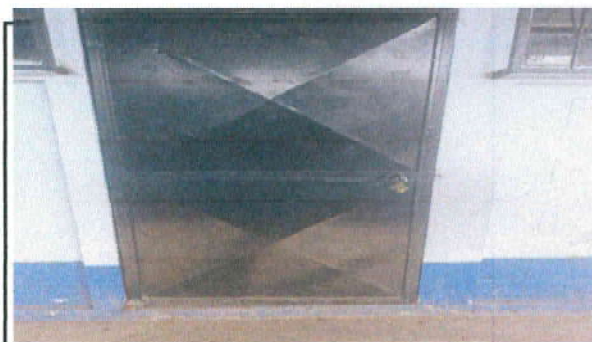
Mantenimiento a estructuras lijado y pintura.
