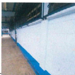
Foto 5: pintura en muros interiores y exteriores
