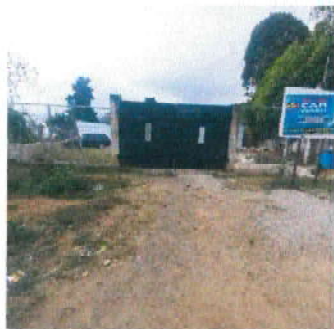
Foto 1: reparación de portón
