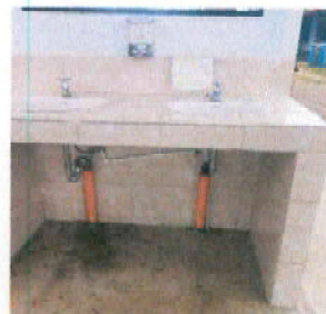
Foto 4: reparación de lavamanos
