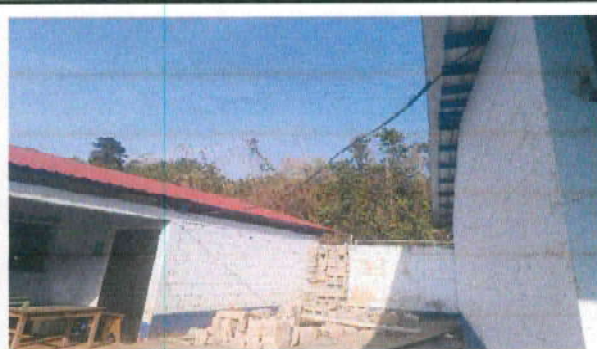
Sustitucion de cableado electrico
