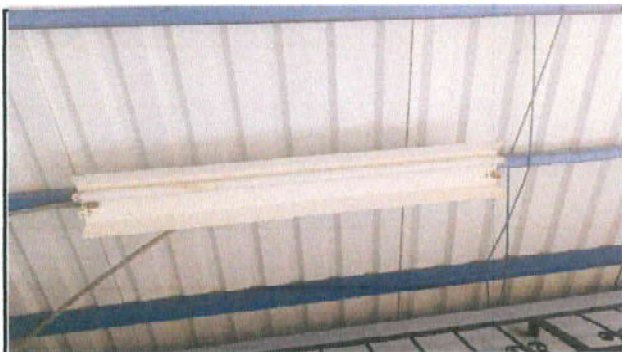
Sustitución de lamparas LED, por focos ahorradores
