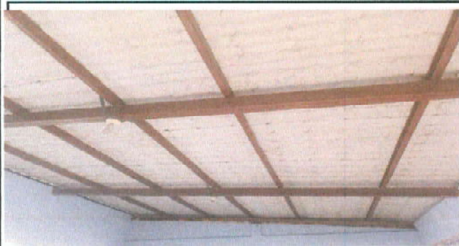
Cambio de techo, lamina calibre 26
