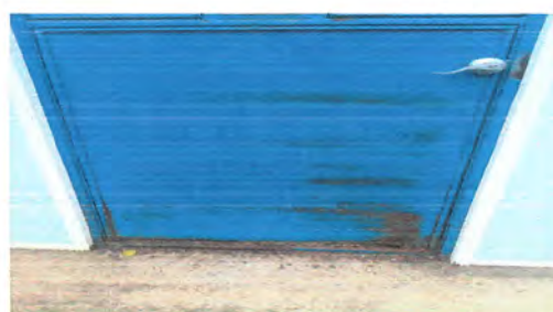
Foto 2: Reparación y mantenimiento a puertas de metal en cocina pvc, (cambio de tubo, cambio de lámina y aplicación de pintura anticorrosiva).
