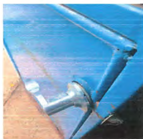
Foto 3: sustitución de chapas.
