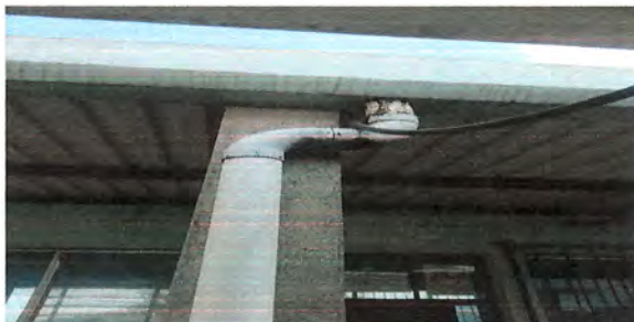
Foto 9 : Sustitución de tubo PVC de, 3" en bajadas de agua
