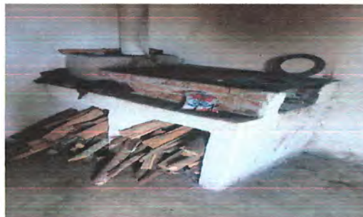
Foto 8: instalación de azulejo en estufa rural
