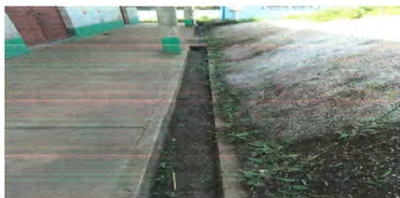
Foto 11: Reparación de cuneta de concreto.
