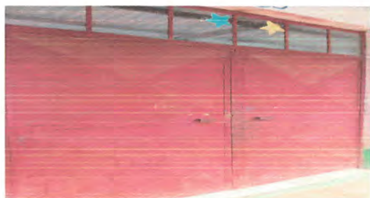
Foto1: Mantenimiento a puertas de aulas, (lijado cepillado y aplicación de pintura anticorrosiva).
