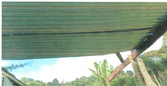
Foto7: sustitución de lámina, por lámina troquelada aluzinc calibre 26 y sustitución de estructura de soporte de madera, por metal, en el patio de la escuela.
