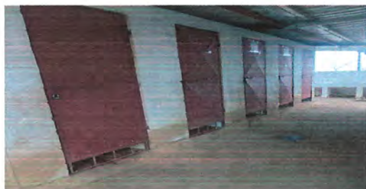
Foto 5: Reparación y mantenimiento a puertas de sanitarios (lijado, cambio de tubos y aplicación de pintura anticorrosiva).
