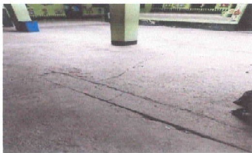
Foto 1: Reparación de piso de torta de cemento
