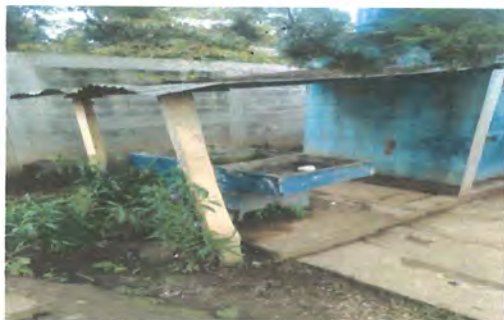
Foto1: Sustrucción de lámina por lámina troquelada calibre 26
