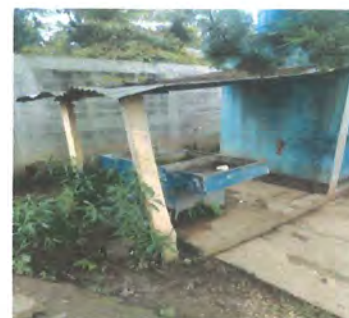
Foto 4: Sustrucción de pila (incluye instalación hidráulica, drenaje y fundición de concreto)
