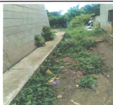
Foto 6: Mejoramiento de banqueta de concreto
