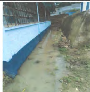
Foto 4: 8. Mejoramiento de cuneta de concreto
