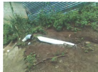
Foto 6: Sustrucción de tubería de drenaje de PVC y recubrimiento de concreto (1.50 m) en tramo descubierto
