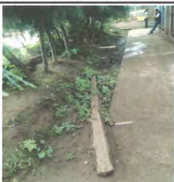
Foto 5: Mejoramiento de banqueta de concreto
