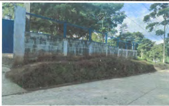
Foto 2: Aplicación de base + pintura en muros perimetral de establecimiento
