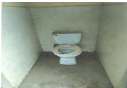
Foto 5: Sustrucción de inodoros en mal estado
