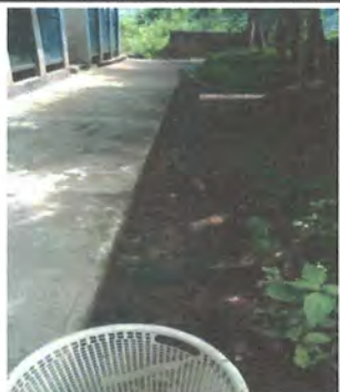
Foto 3: Mejoramiento de cuneta con bordillo de block para evitar bloqueo con lodo
