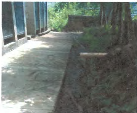
Foto1: Reparación de cuneta de concreto
