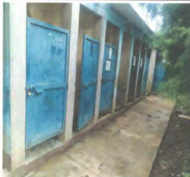
Foto1: 4. Sustitución de puertas de metal en baños
