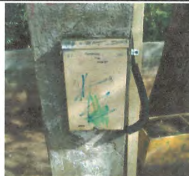
Foto 4: Sustitución de flipones de 20 Amperios
