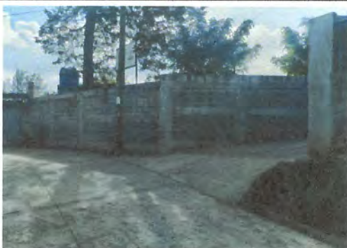
Foto 3: Aplicación de base + pintura en muros perimetral de establecimiento
