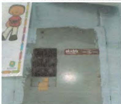
Foto 5: Sustitución de flipones de 20 Amperios
