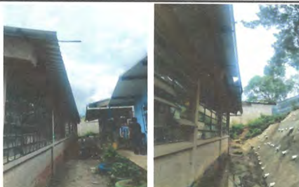
Foto 2: 7. Sustitución de canales de metal y bajadas de agua de 3" para agua pluvial
