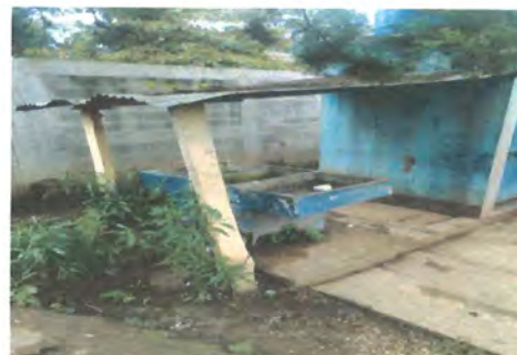
Foto 2: Sustrucción de estructura portante de madera por estructura de metal (incluye bases)
