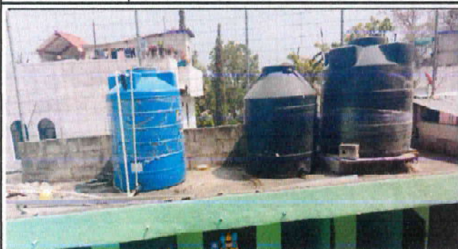
Foto 7: Sustitución de accesorios depósito de agua
