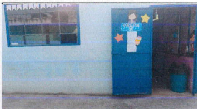
Foto 4: Pintura en muros interiores y exteriores
