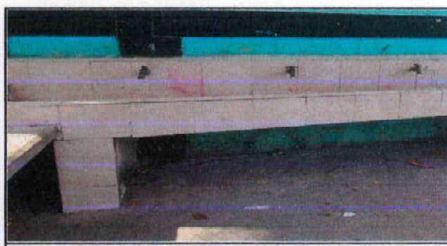
Foto 6: sustitución de llave de chorro
