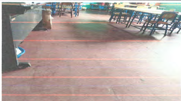
Foto7: Se tiene previsto sustitución piso de granito en aula de párvulos
