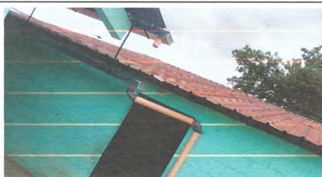
Foto 9: Se tiene previsto sustitución de lámina por lámina troquelada aluzinc calibre 26 y mantenimiento de estructura de techo en aula de tercero primaria
