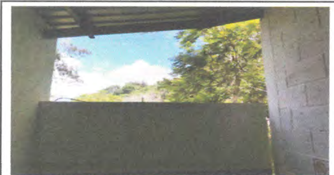
Foto 5: Reparación de muro de block, aplicación de repello, cernido y pintura en parte interior
