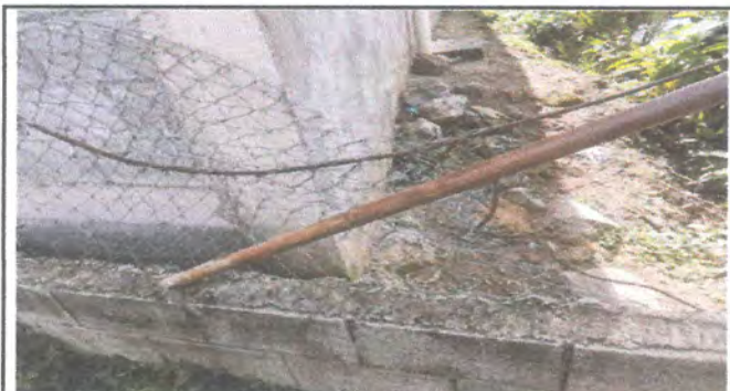
Foto 3: Reparación de muro de malla galvanizada con tubo HG, se instalará malla galvanizada con marco de plana de HG y tubo Galvanizado Chapa 16
