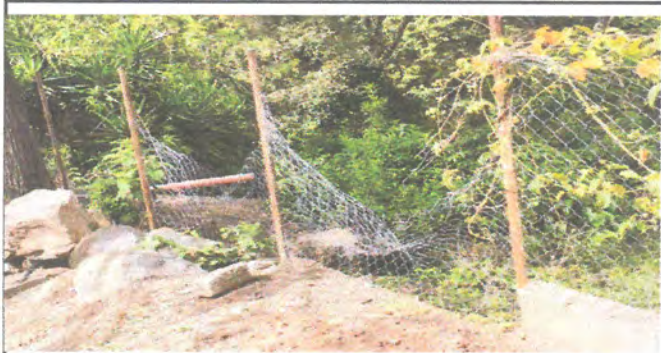
Foto1: Reparación de muro de malla galvanizada con tubo HG, se instalará malla galvanizada con marco de plana de HG y tubo Galvanizado Chapa 16
