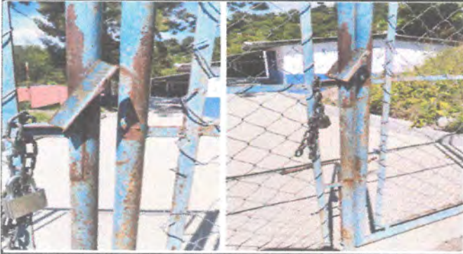
Foto 7: Mantenimiento a estructura del portón, lijado, cepillado, sujeciones, se cambiara toda la malla existente por malla de 1" calibre 13 con marco de plana, aplicación de pintura color plata
