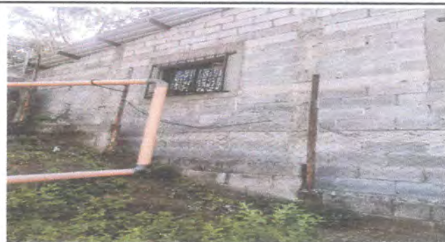
Foto 2: Reparación de muro de malla galvanizada con tubo HG, se instalará malla galvanizada con marco de plana de HG y tubo Galvanizado Chapa 16
