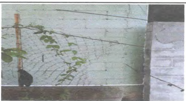
Foto 4: Reparación de muro de malla galvanizada con tubo HG, se instalará malla galvanizada con marco de plana de HG y tubo Galvanizado Chapa 16
