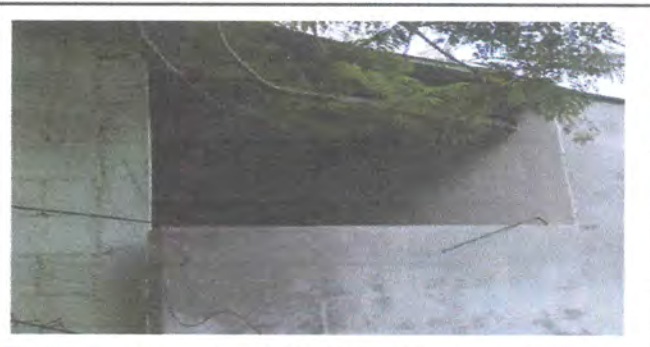
Foto 6: Reparación de muro de block, aplicación de repello y pintura en parte exterior
