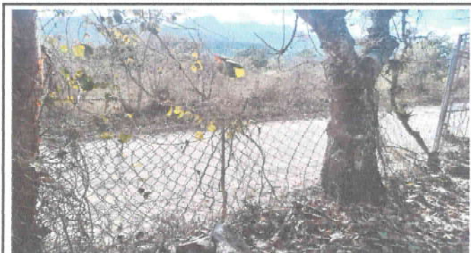
Foto 4: MALLA QUE A QUEDADO EN MAL ESTADO.
