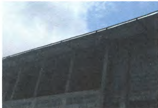
Foto 1: Sustrucción de canales con bajada de agua pluvial
