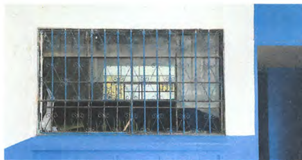
Foto 6: Sustrucción de balcones de metal en ventanas
