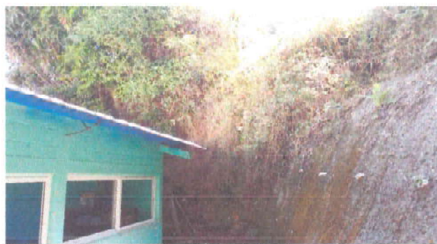
Foto 4: Sustitución de sabieta de muro de contención (colocación de electromalla calibre 6/6). Para evitar alguna tragedia, ante algún desastre natural.
