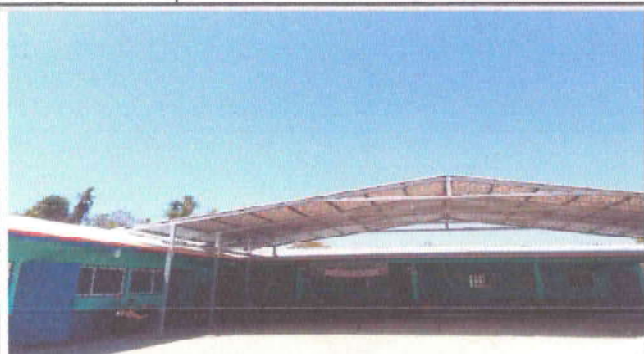
Foto 1: Instalación de lámina troquelada aluzinc (calibre 26).
