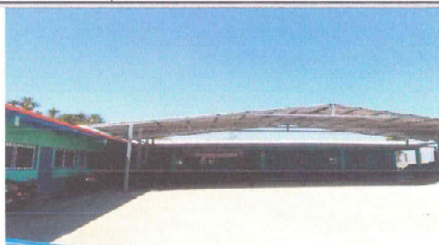
Foto 2: Instalación de lámina troquelada aluzinc (calibre 26).
