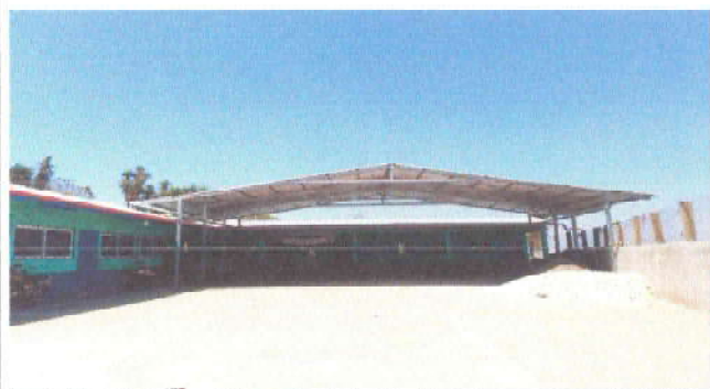
Foto 3: Instalación de estructura de metal.
