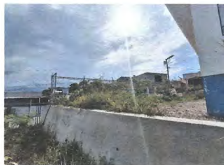
Foto 4: Mejoramiento de muro perimetral con malla y tubo de metal para seguridad de los niños
