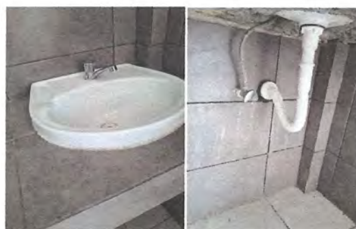
Foto 6: Sustitución de llave mezcladora en lavamanos de baños
