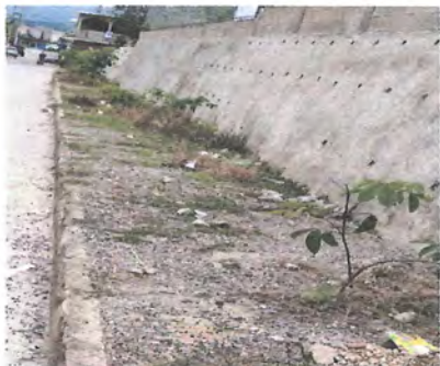
Foto 1: Mejoramiento de banqueta de concreto
