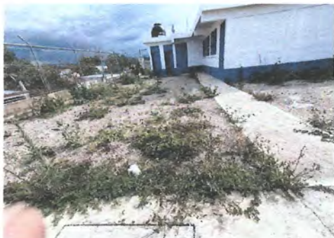
Foto 3: Ampliación de torta de concreto en patios (espesor de 8 cm)
