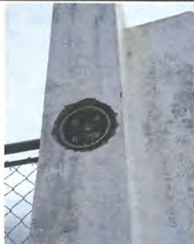
Foto 1: Sustitución de acometida eléctrica debido a malas condiciones en las que se encuentra
