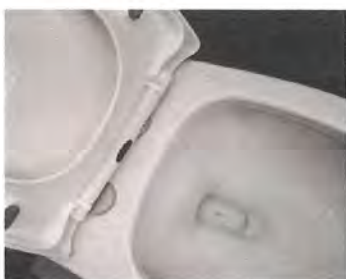
Foto 3: Sustitución de accesorios de sanitarios
