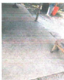
Foto 7: LOSA DEL PATIO DE LA EORM LAGUNA MONJA BLANCA.
