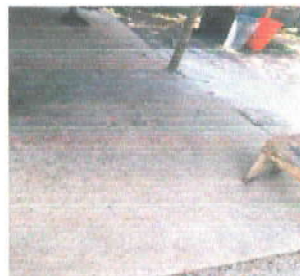
Foto 8: LOSA DEL PATIO DE LA EORM LAGUNA MONJA BLANCA.
