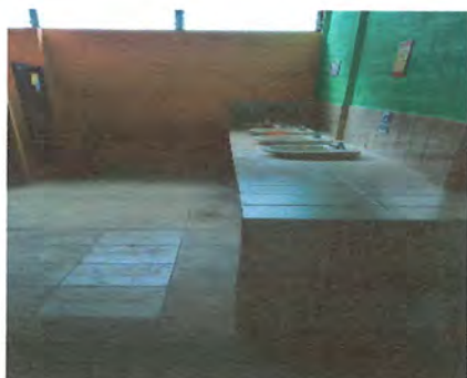
Foto 3: Sustitución de accesorios en inodoros y lavamanos de baños de niños
