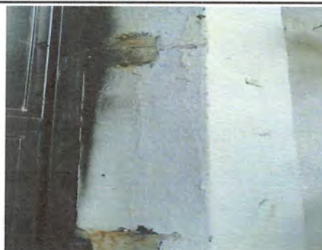
Foto 6: Mantenimiento a puerta metálica debido a mal estado de su estructura
