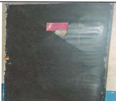
Foto 5: Sustitución de puerta metálica por puerta nueva metálica
