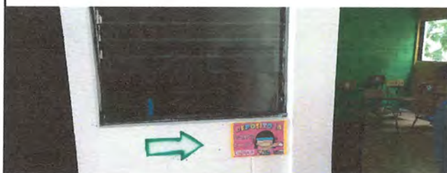
Foto 11: Sustitución de vidrios en ventanas de establecimiento
