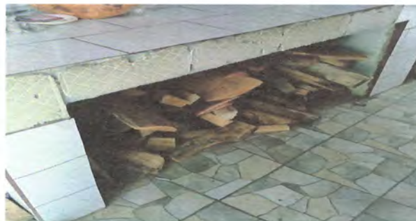
Foto 8: Sustitución de azulejo en mueble de cocina
