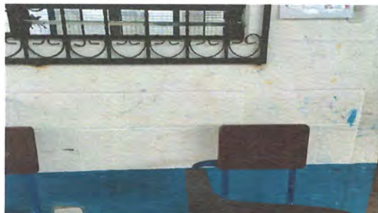
Foto7: Sustitución de pintura en muros interiores y exteriores de aulas del establecimiento
