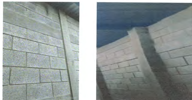
Foto 2: Mantenimiento de muro de cocina, incluye repello y cernido
