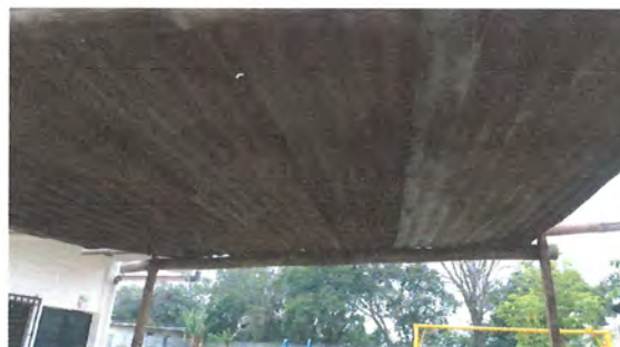
Foto 10: Sustitución de estructura portante de madera para techo por estructura portante de metal
