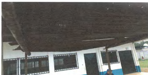
Foto 9 : Sustitución de lámina existente por lámina troquelada calibre 26
