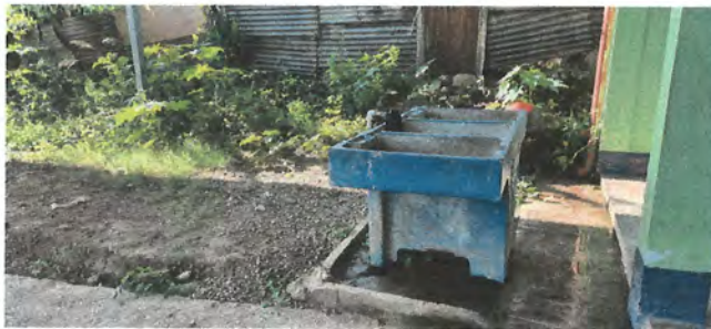
Foto 17: Sustrucción de caja de registro.
