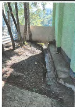
Foto 5: Reparación de cuneta de concreto. 145 ML
