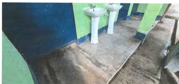
Foto 2: Sustitución de piso cerámico en área de sanitarios
