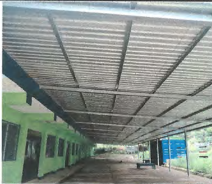
Foto 15: Instalación de 3 unidades luz (incluye interruptor, ducto y cable eléctrico)
