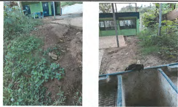
Foto 18: Sustrucción de tubería línea principal.
