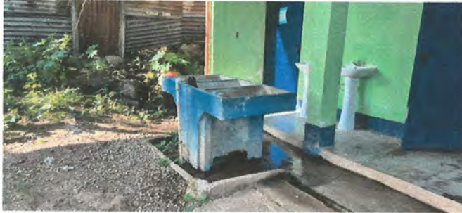
Foto 13: Sustrucción de pila de cemento de 2 dos lavaderos
