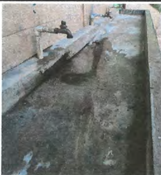
Foto 11: Sustitución de 3 llaves de chorro.
