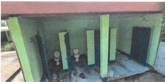
Foto 9: Sustitución de 6 inodoros.
