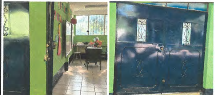
Foto 14: Sustrucción de una puerta de metal en módulo.
