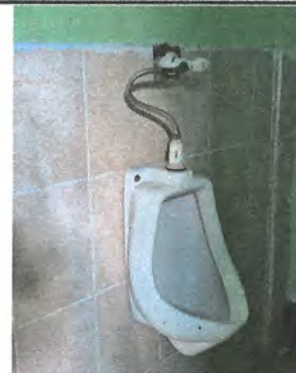
Foto 10: Sustitución de llave en mingitorio.
