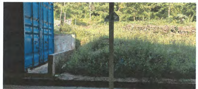
Foto 12: Instalación de 3 lavamanos.
