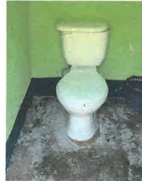
Foto 8: Sustitución de accesorios de inodoro (contra llave, tubo de abasto y tanque).
