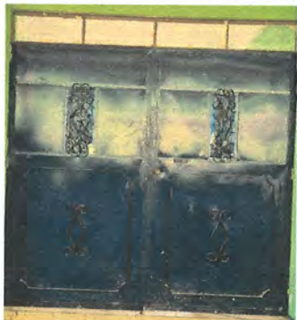
Foto 1: Mantenimiento a 12 puertas metálicas (lijado, cambio de tubo, cepillado, sujeciones, aplicación de pintura).
