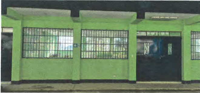
Foto7: Sustitución de pintura en muros exteriores e interiores
