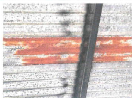
Foto 5: Foto 3: Cambio de lámina del patio por oxidado
