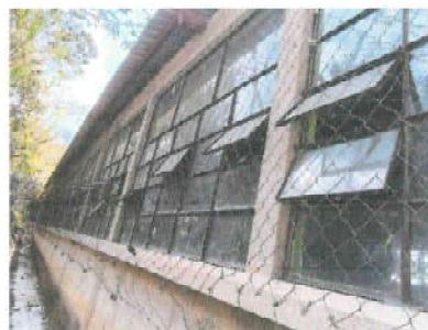
Foto 2: Cambio de malla en la parte de afuera por balcones para brindar mayor seguridad.
