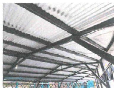
Foto 6: Cambio de lámina de segunda por lámina troquelada y así prevenir daños a futuro.
