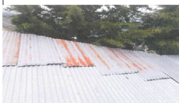
Foto 4: Cambio de lámina en mal estado y de mala calidad por lámina troquelada.
