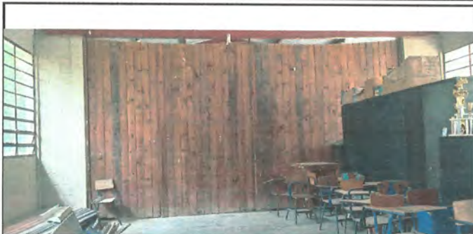
Foto7: Sustitución de portón divisor de madera por uno con marcos de metal y planchas de playwood
