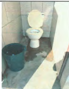
Foto 9: Sustitución de inodoros y piso de torta de concreto
