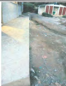
Foto 3: Sustitución de banqueta frente a módulo de aulas
