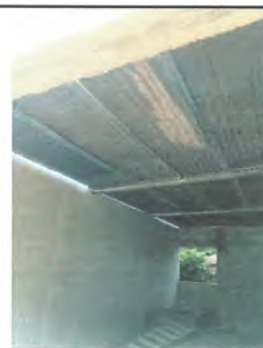
Foto 4: Sustitución de lámina, estructura portante metálica, repello y cernido, torta de cemento , iluminación y tomacorrientes. Puerta y ventanas de metal
