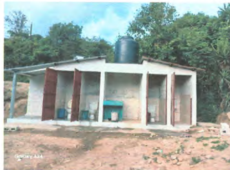
Foto 8: Sustitución de piso de torta de concreto
