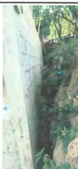
Foto 5: Impermeabilización en lado externo de pared de módulo de cocina, por estar bajo el nivel de la parte superior del centro educativo.
