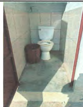
Foto 10: Sustitución de inodoros y piso de torta de concreto
