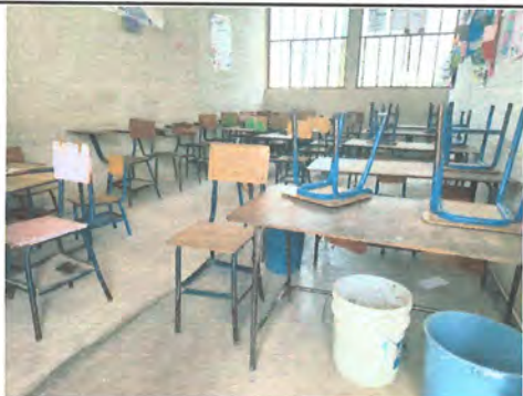
Foto1: Sustitución de torta de concreto y socalo
