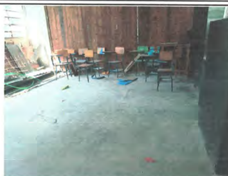
Foto 2: Sustitución de torta de concreto y socalo
