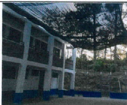
Foto 3: Suministro e instalación de estructura de soporte de metal
