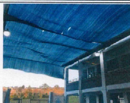
Foto 2: Instalación de lámina troquelada aluzinc, calibre 26.
