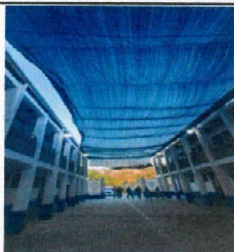
Foto1: Instalación de lámina troquelada aluzinc, calibre 26.
