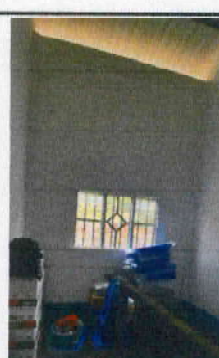
Foto 6: Suministro e instalación de unidades de luz y tomacorrientes en bodega
