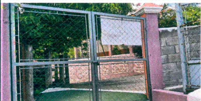
Foto 5: Sustitución de portón de metal
