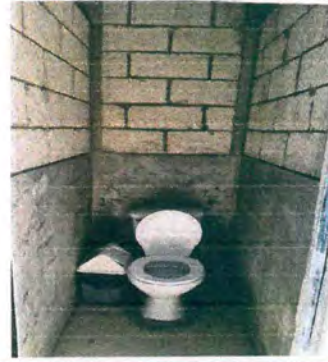
Foto 10 Sustitución de inodoro
