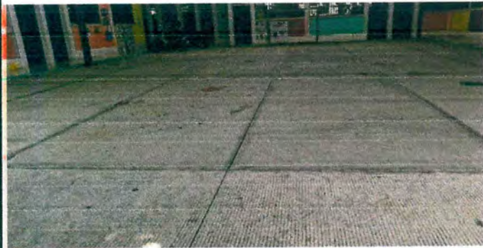
Foto 7: Pintura de cancha
