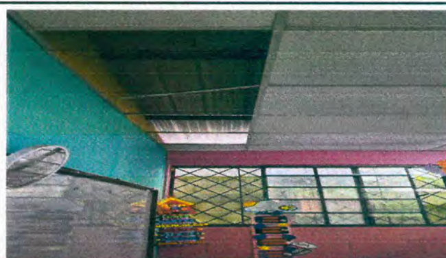
Foto 2: Sustitución de cielo falso reticulando 2 aulas cocina y baños.
