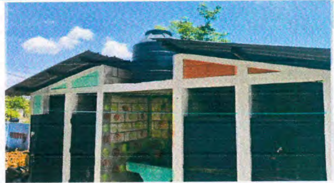
Foto 8: Mantenimiento a estructura (lijado, cepillado, aplicación de pintura) servicios sanitarios.
