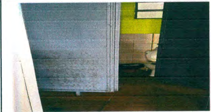
Foto 9: Mantenimiento a estructura (lijado, cepillado, aplicación de pintura) divisiones de sanitarios.
