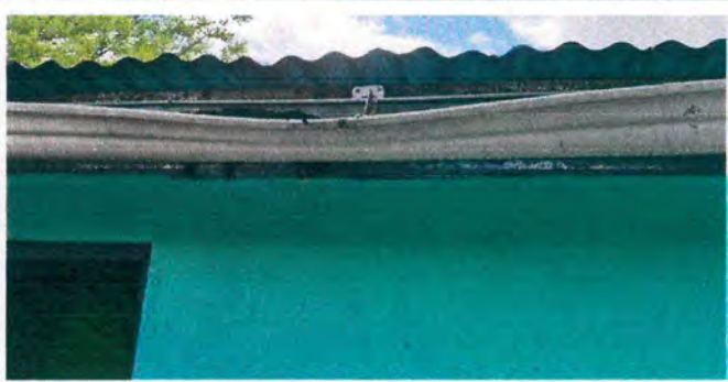
Foto 6: Sustitución de canal de pvc
